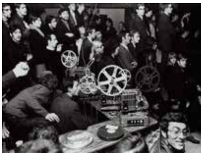
Abb. 1: Projektion der Underground-Filme in der U-Bahn-Baustelle Neumarkt
